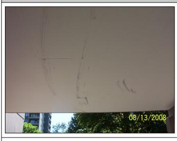
View of impact mars on the porte cochere soffit.
